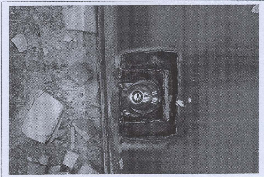
< 도어락 설치 부근 - 도어락 ㄷ자 보강 >
